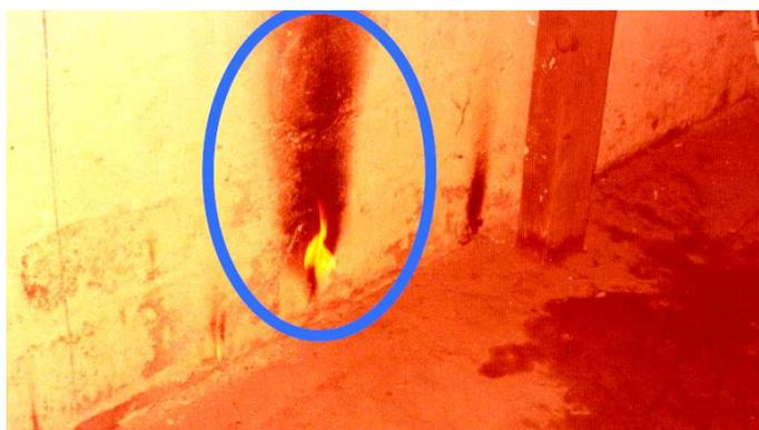
**Fotografia 1** - Combustão de gases e vapores provenientes de uma fonte subsuperficial
